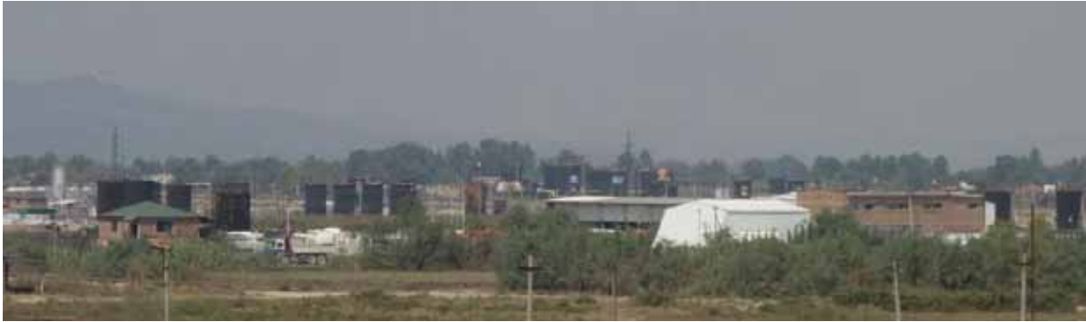
Abbildung 76: Förderanlagen des Marinza-Ölfelds. Die Bäume im Hintergrund links zeichnen den morphologischen Buckel des Dumre-Salzdoms nach.
